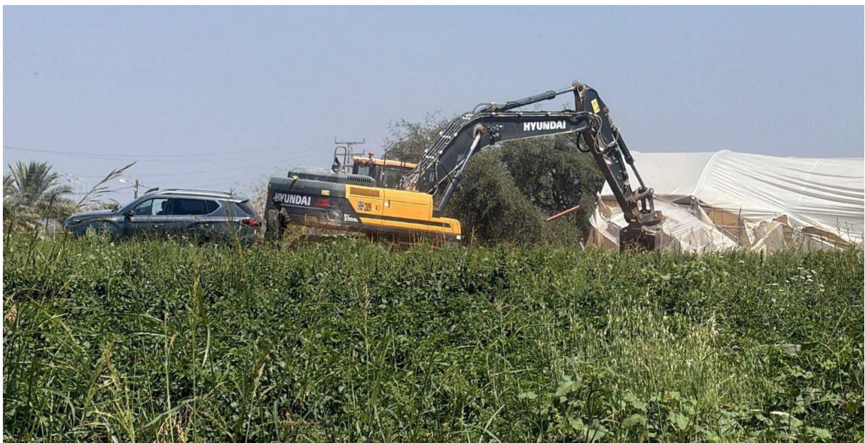
Demolizione di una serra nella Valle del Giordano, dicembre 2025
